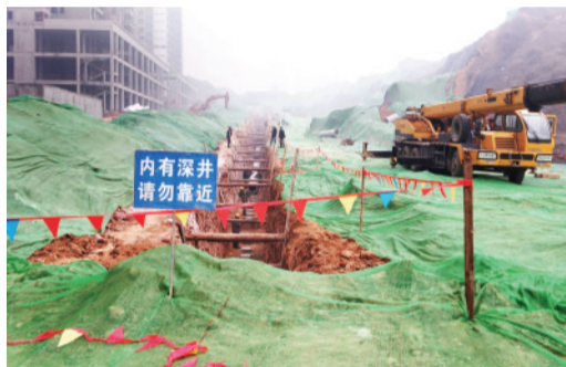
正在建设中的航天中路
